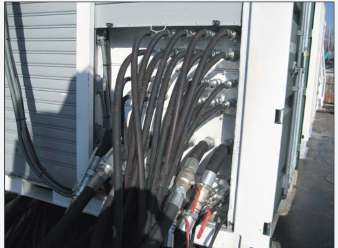
Figura 5 - Gli attacchi rapidi di tubazione
