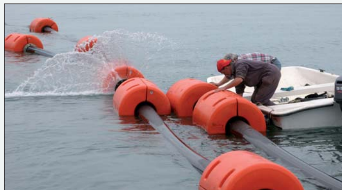
Figura 10 - Il montaggio di tubi convenzionale
